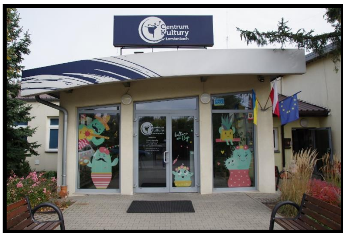
Wejście główne do budynku
